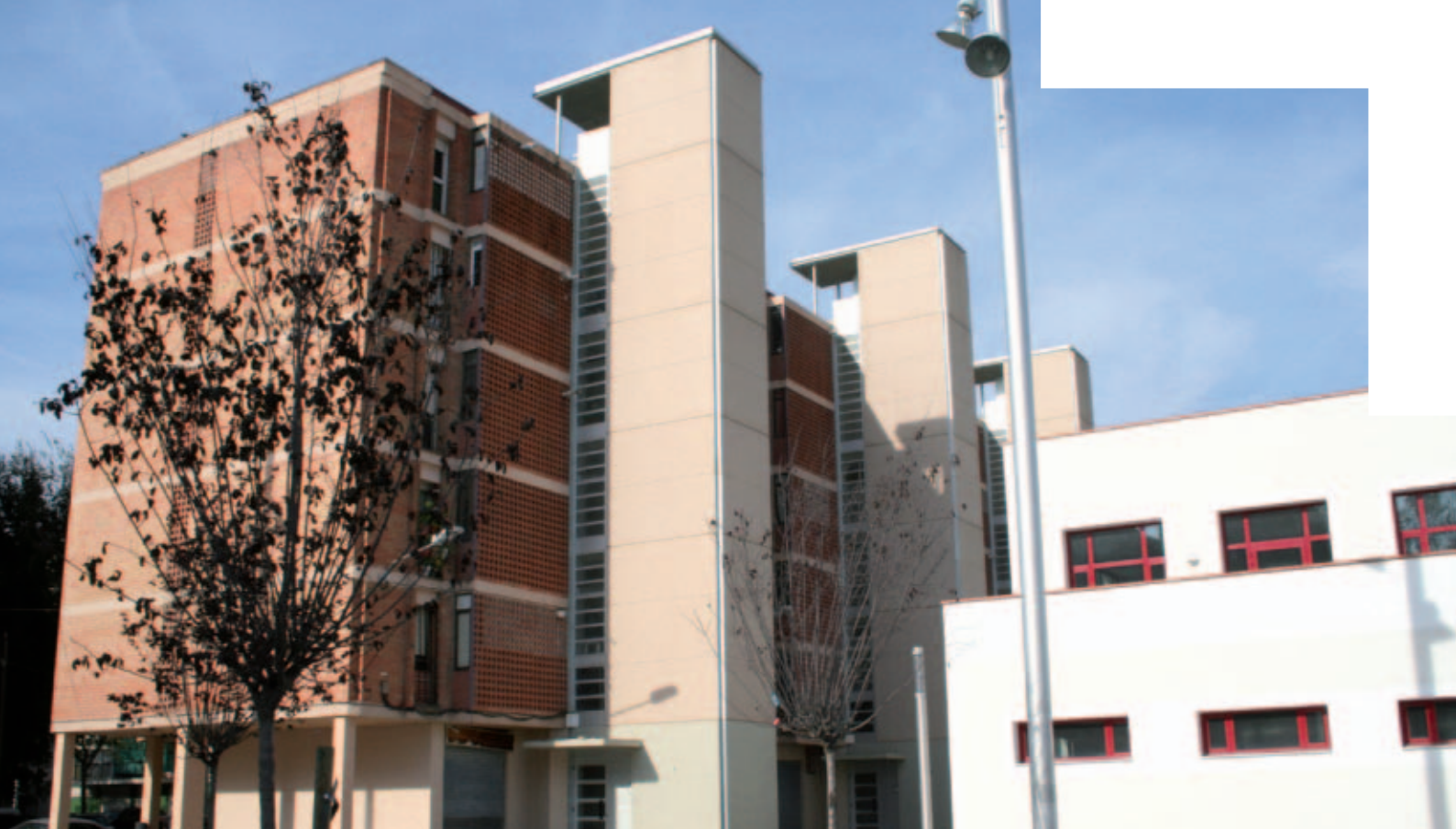
Instalación de ascensores adosados en el Mina Vieja que aprovechan el espacio entre bloques. 300 familias se benefician de esta mejora.
