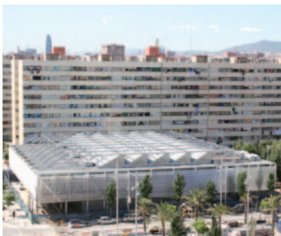
La biblioteca de la Mina es un edificio emblemático de amplios espacios y con mucha luz.
